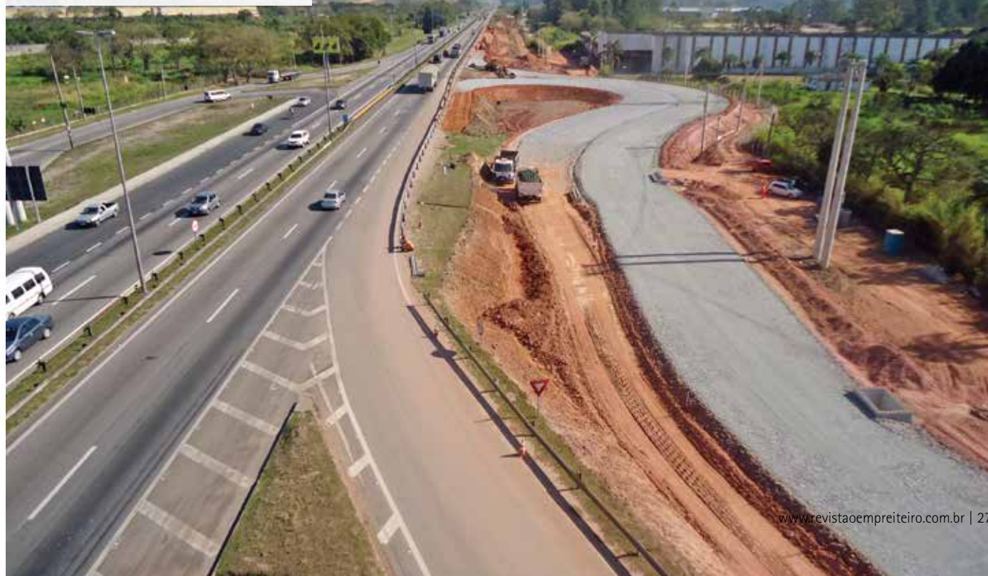
Trevo do km 162 da Dutra, em Jacareí (SP). Obra da CCR NovaDutra prevista para janeiro
