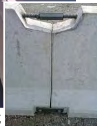
Módulos interligados pela barra de aço (em cima) e placas de aço (embaixo)
