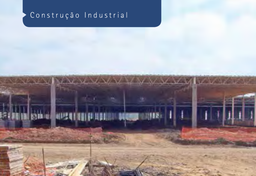
A montagem das estruturas pré-moldadas de concreto levou dois meses; já a estrutura da cobertura teve cinco meses de trabalho
