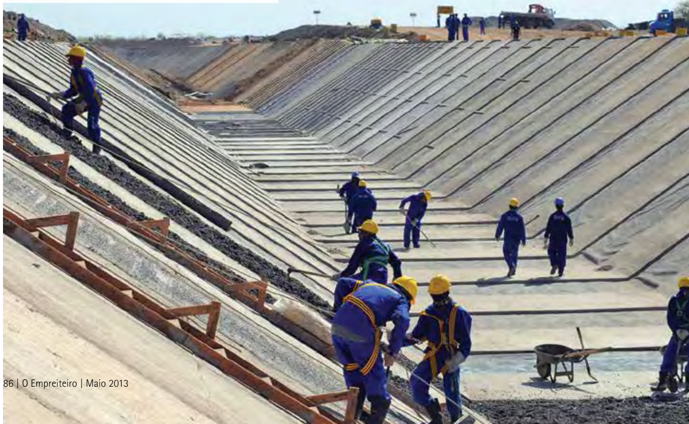
Obras de construção de canais do lote 1, em Cabrobó (PE)
