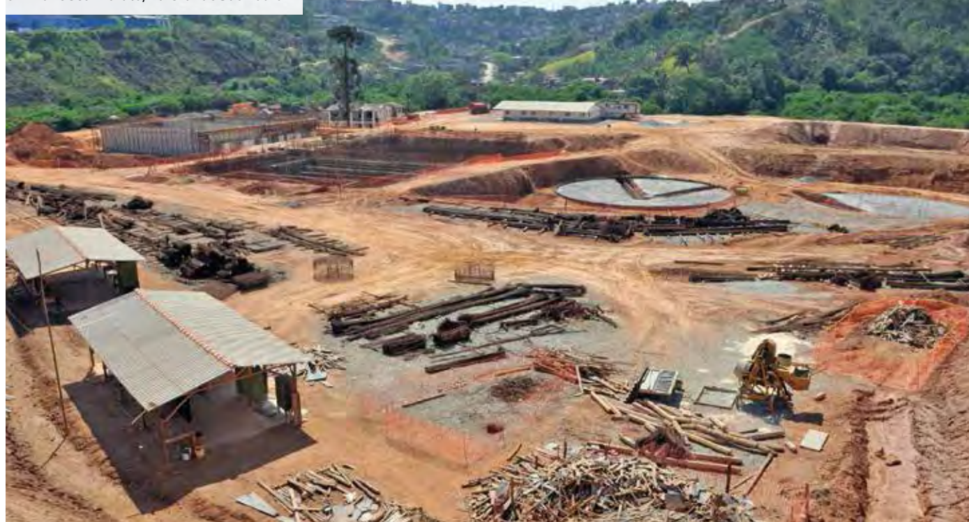
Obra de nova estação de tratamento de água em Francisco Morato, na Grande São Paulo
