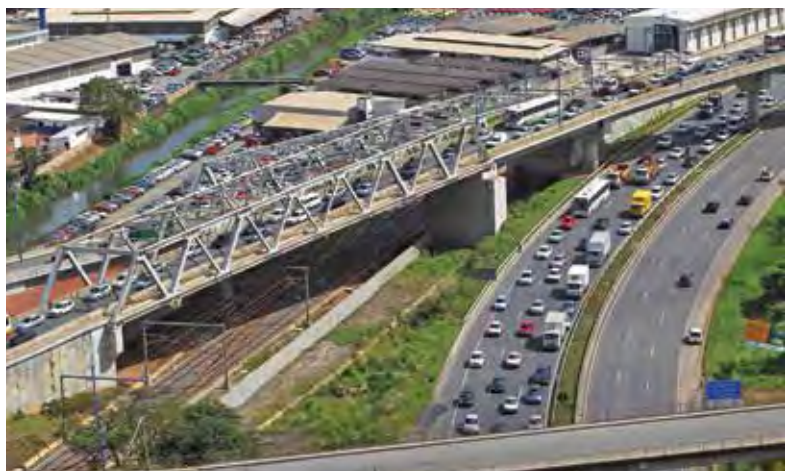
Via Expressa Bahia de Todos os Santos encurta e facilita o acesso ao porto de Salvador
