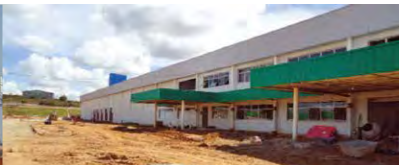
A fábrica da Latapack (vista das fases de construção e acabamento) foi dimensionada para uma produção compatível com a demanda das unidades de bebidas implantadas na região
