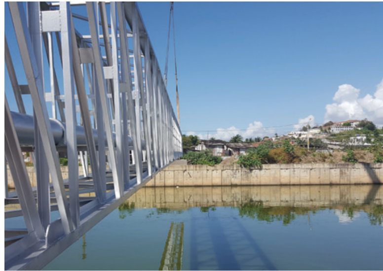
Projeto minucioso permitiu execução de eficiente rede de distribuição de água
