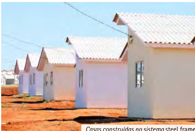
Casas construídas no sistema steel frame
