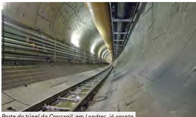
Parte do túnel da Crossrail, em Londres, já pronta
