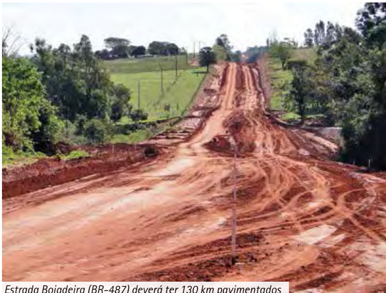
Estrada Boiadeira (BR-487) deverá ter 130 km pavimentados
