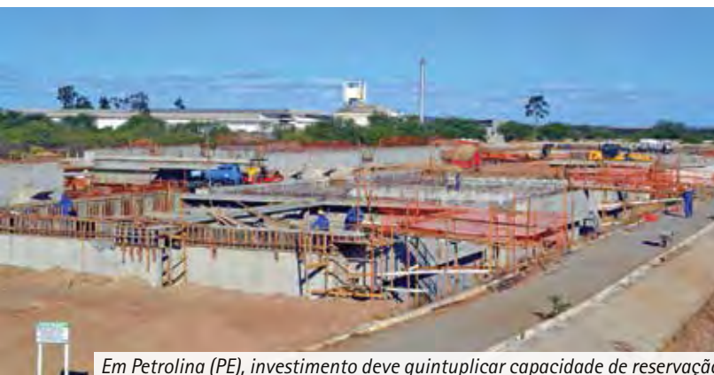
Em Petrolina (PE), investimento deve quintuplicar capacidade de reservação de esgoto
