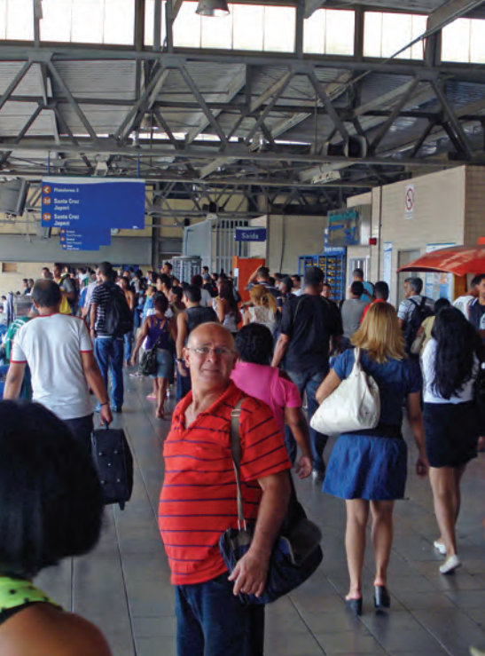
Estrutura arcaica no Terminal Deodoro
