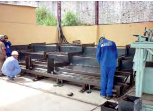
A construtora desenvolveu fôrmas específicas para a pré-moldagem das arquibancadas e das escadas
