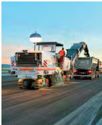
W250 é a fresadora mais sofisticada da Wirtgen, com dois motores somando 980 HP, capacidade para produzir 1300 t/h de material cortado, largura de trabalho de 2,2 a 4,4 m, profundidade de até 35 mm
