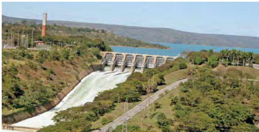
Há exatamente 49 anos começava a funcionar a usina hidrelétrica de Três Marias, no rio São Francisco, construída com recursos da então Comissão do Vale do São Francisco (CVSF), sob a administração da Cemig. Foi um marco, em sua época, com barragem de 2.700 m de extensão e capacidade instalada inicial de 396 MW
