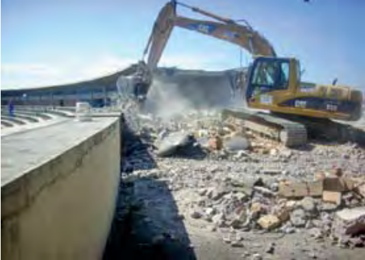
Primeira etapa: obras de demolição do antigo estádio. Em seguida, a terraplenagem, e depois as fundações
