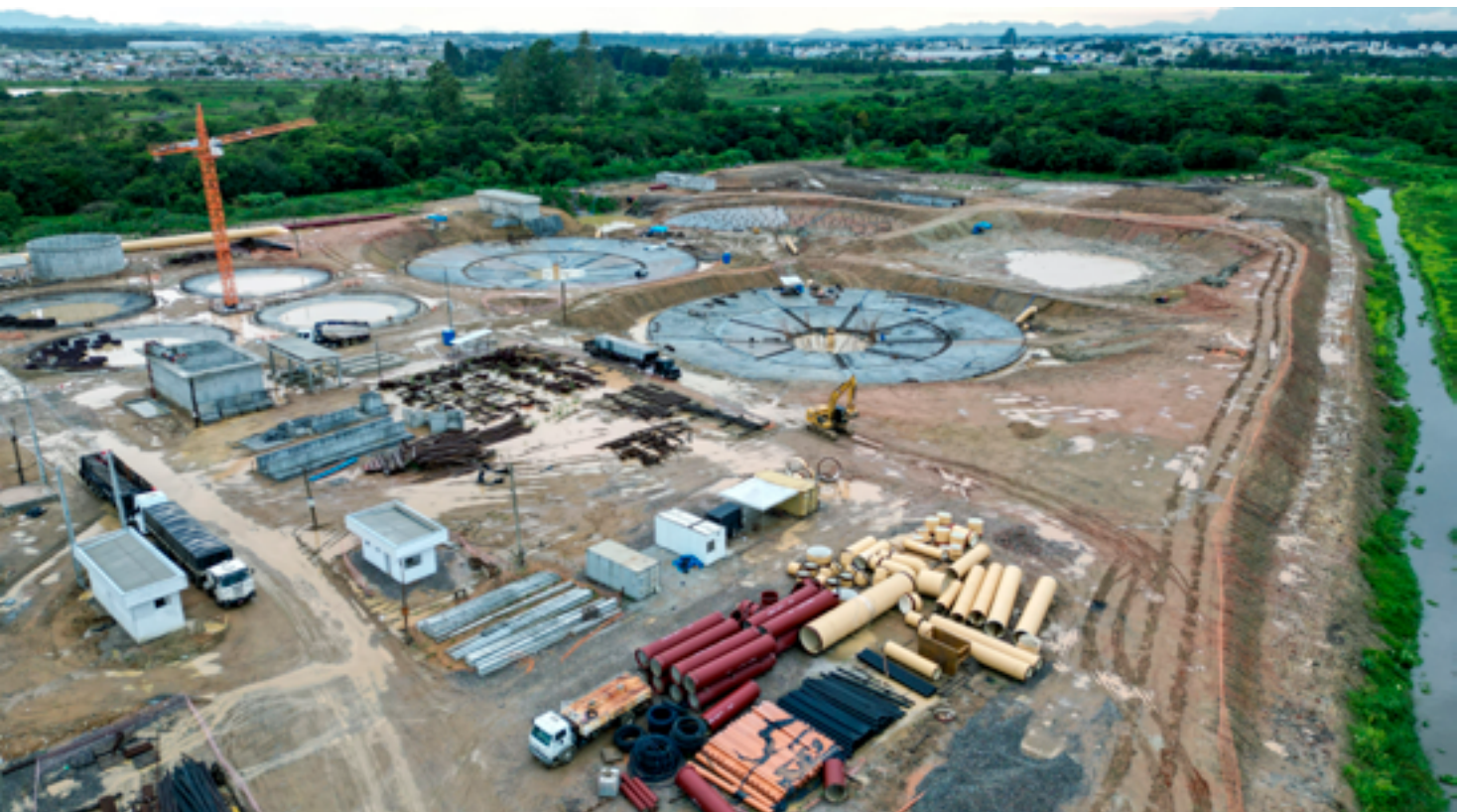
Canteiro de obras da Sanepar
