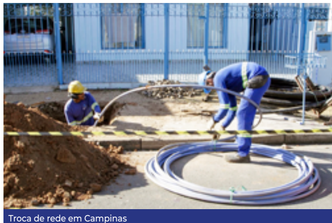
Troca de rede em Campinas
