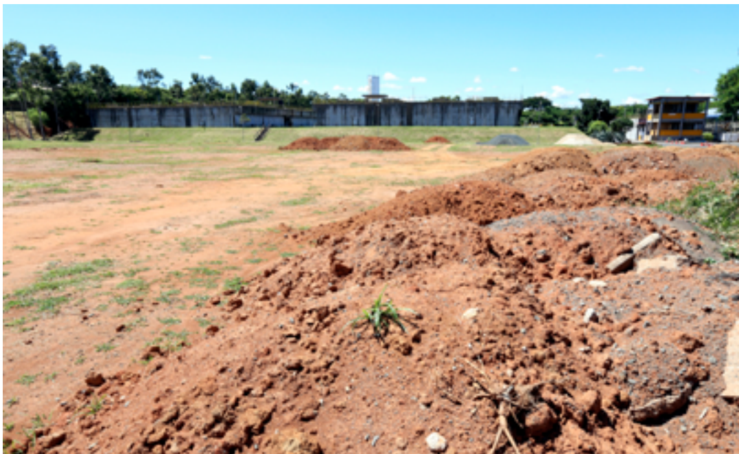
Obras de esgotamento sanitário em Campinas
