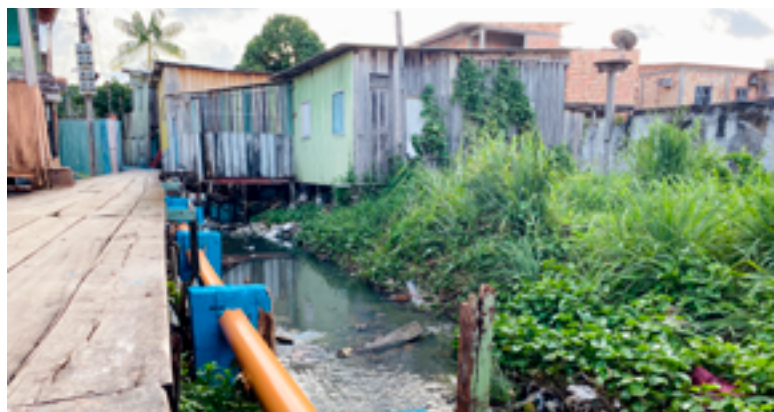
Tubulação instalada em Beco do Nonato, em Manaus
