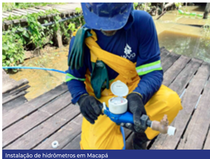
Instalação de hidrômetros em Macapá
