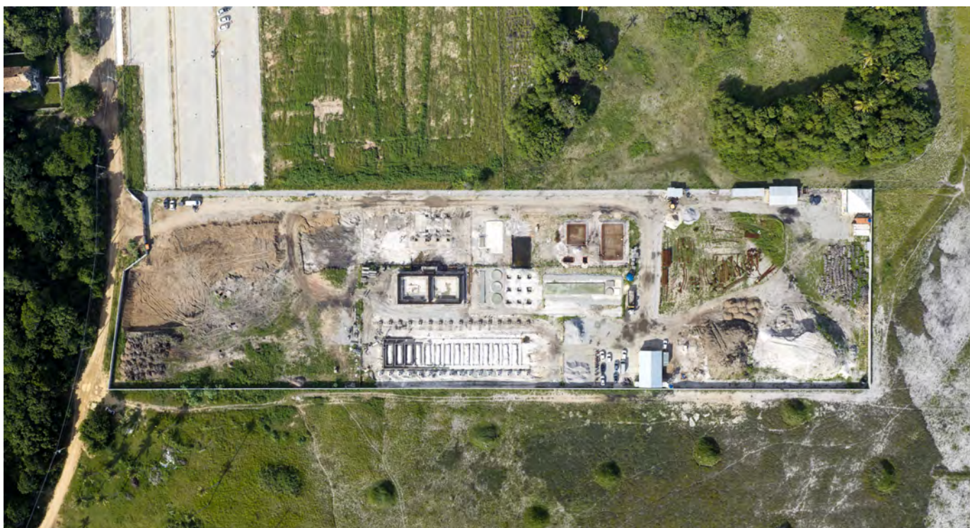
Estação de Tratamento de Esgoto (ETE) Norte
