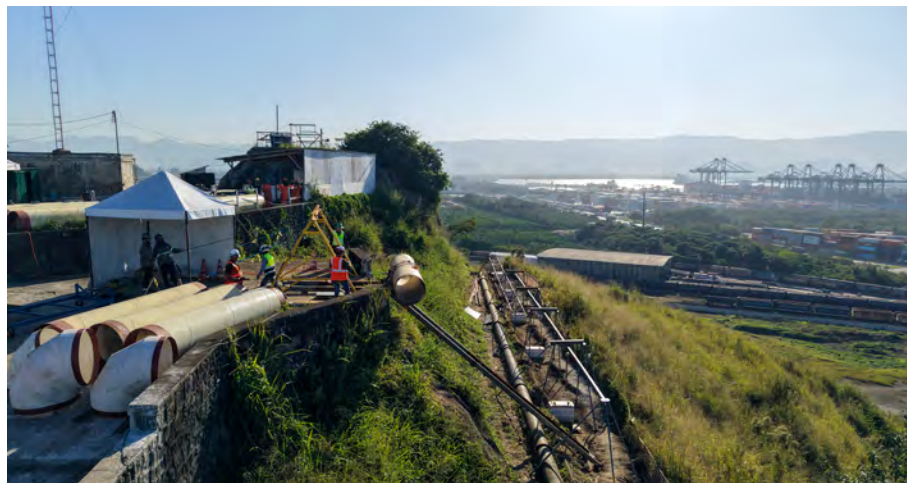
Tubulação em instalação no Sabó, em Santos, ponto de partida da adutora
