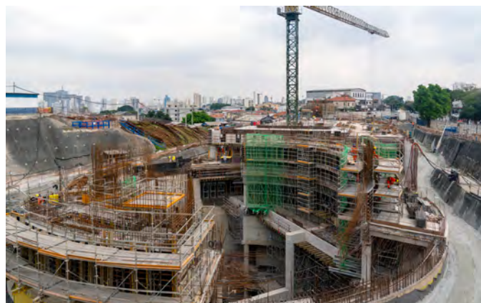
Obras Estação Santa Clara
