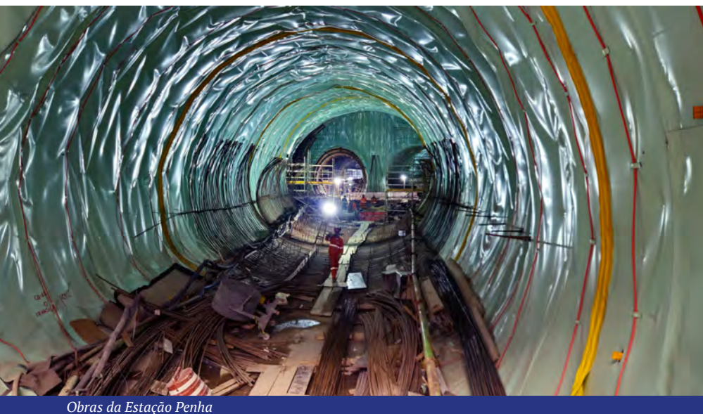
Obras da Estação Penha
