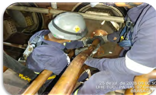
UG07 – Instalação do barramento de neutro.
