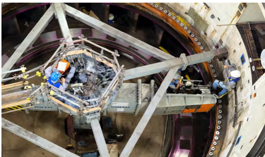
Modernização da UHE Paulo Afonso
