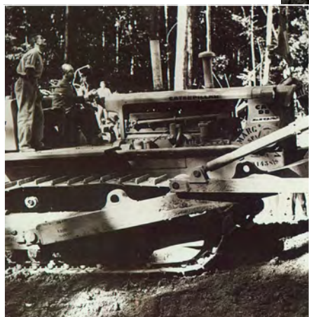
Trator da marca na construção de Brasília
