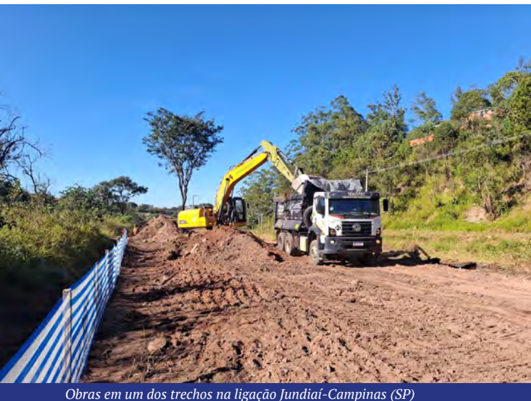
Obras em um dos trechos na ligação Jundiaí-Campinas (SP)
