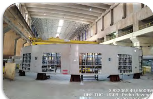
5º Estator – Concluída a montagem da carcaça.
