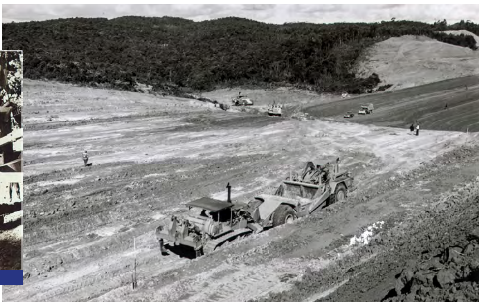
Máquinas Caterpillar em operação nas obras da Rodovia dos Imigrantes (SP), em 1974
