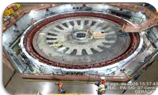
UG07 – Vista do rotor no poço.
